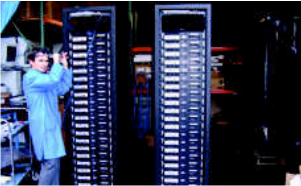
Afbeelding 2: computer racks in magazijn
