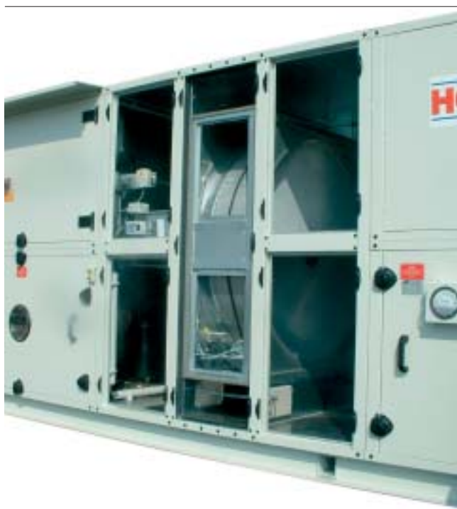
3. Warmteterugwinning met een roterend warmtewiel.
