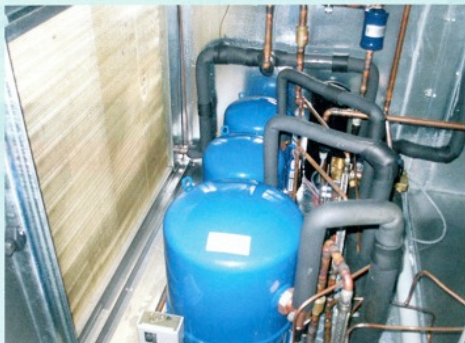
Cascade-opstelling van compressoren. Ze leveren drie verschillende vermogens.
