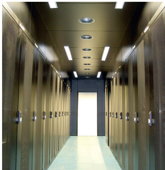
3. In een afgesloten 'cold corridor' kan met hogere temperaturen worden gekoeld.
